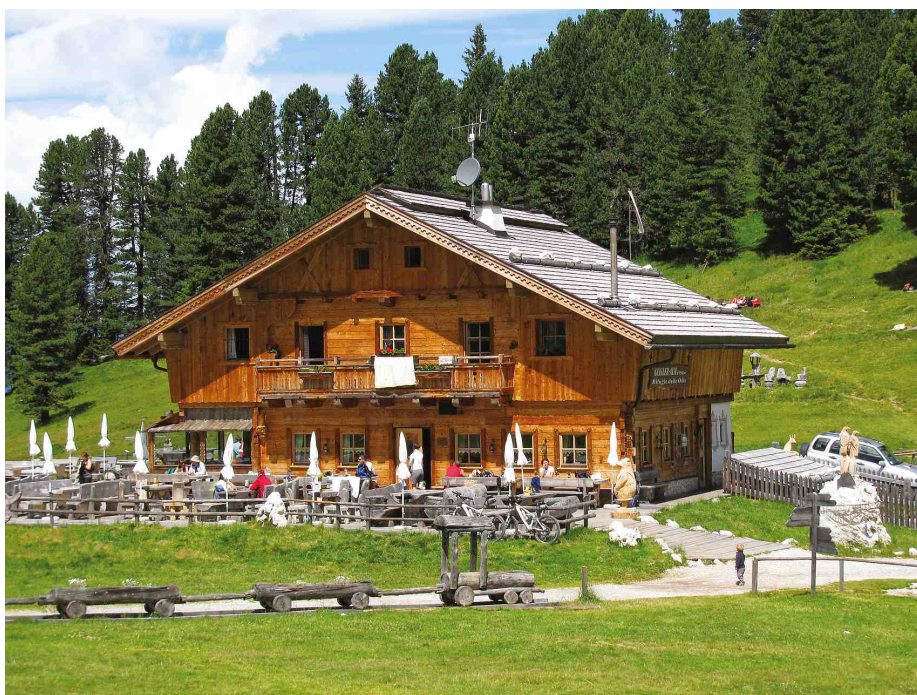
Flüssiggas lässt sich ebenso leicht lagern wie transportieren und ist im Einsatz enorm flexibel und vielseitig.
